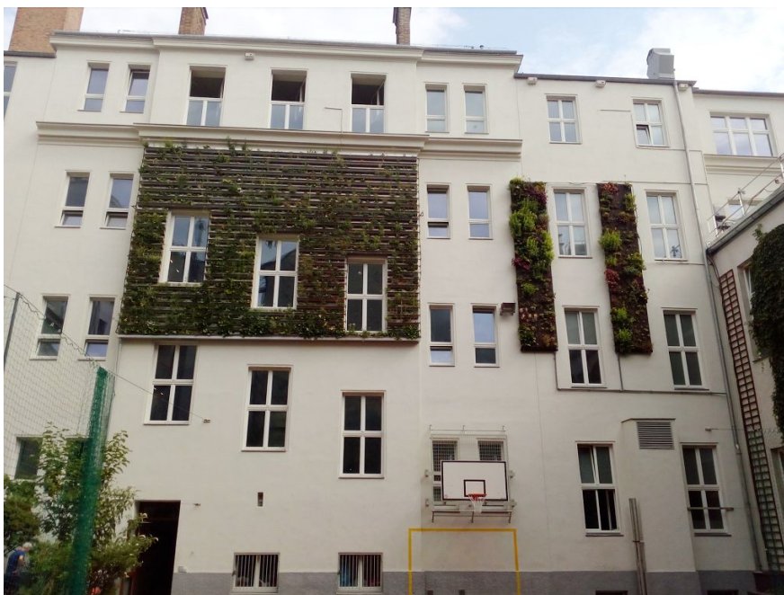
Figure 4: Nach Süden ausgerichtete Fassade des Schulhofes mit Begrünungssystemen
